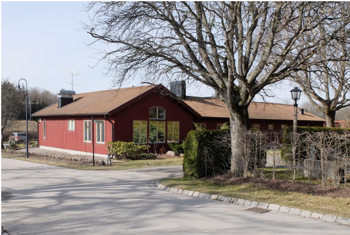
Figur 12. Den befintliga personalbyggnaden. Foto Tyréns.
