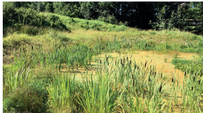
Bild 21 Infiltrations- och reningsdammen i Håjums Begravningsplats, Trollhättan.
