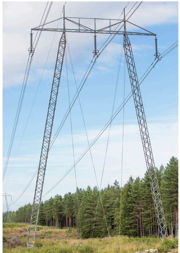
Figur 2.1 Exempel på portalstolpe.
