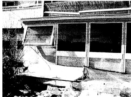
Bilden visar tillbyggnaden under rivning
