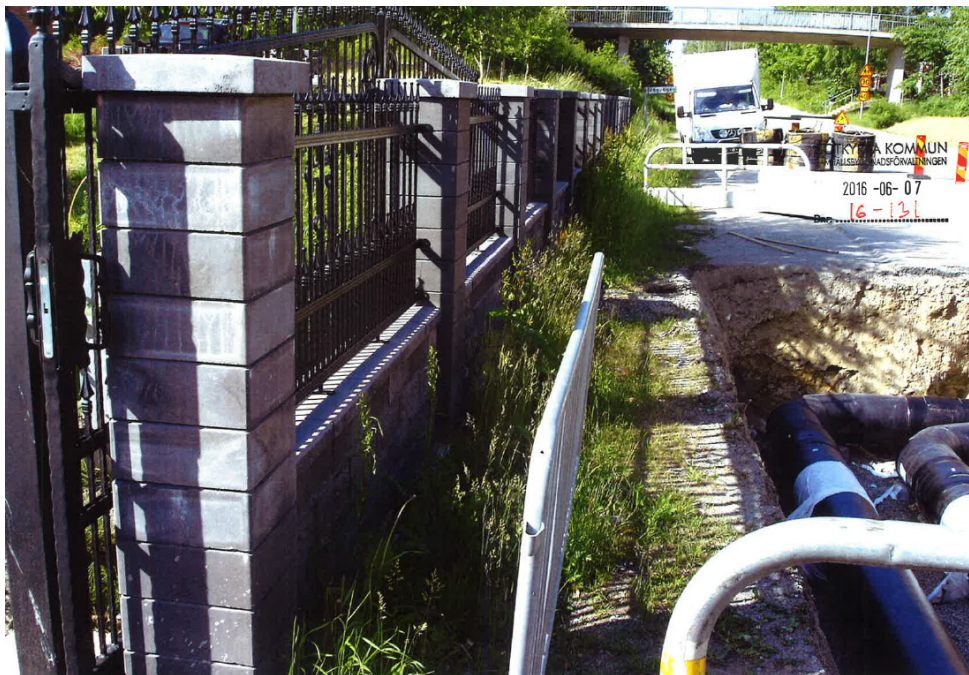
Bilden visar muren och att den ligger drygt 1 meter ifrån rördragningen
