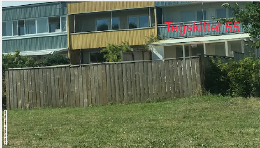
Fotografiet visar plank och skärmtak på fastigheten Tegskiftet 55
