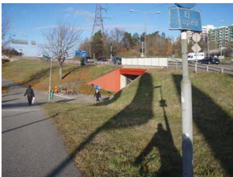
Figur 23 Gångtunnel mellan Eriksberg och Alby.
