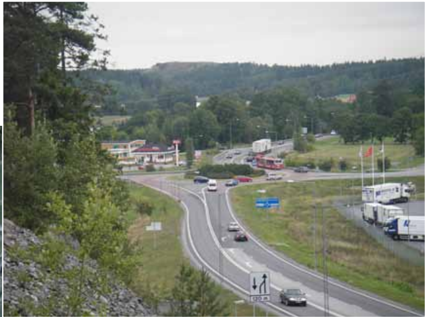
Figur 45 Tunarondden - kapacitetshöjning till två körfält kräver ombyggnad av anslutande vägar i huvudriktningen
