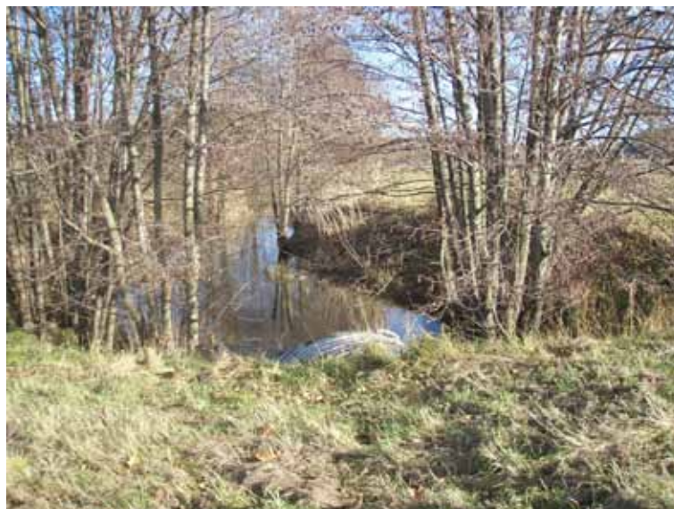
Figur 32 Älvestaån tar emot dagvatten.
