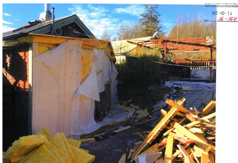
Bilderna 9-10-11 fotodokumentation underlag för slutbesked
