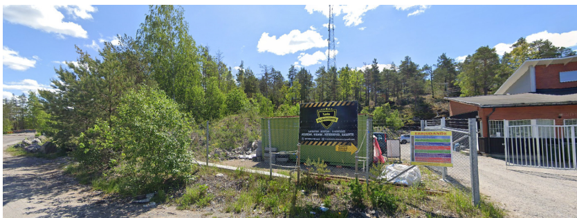
Bild 4 Markåtgärder uppfyllnad på fastigheten Tumba 8:7 från år 2017
