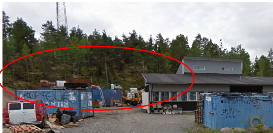
Bild 3 – tagen år 2015, uppställning av container, schaktning mm
