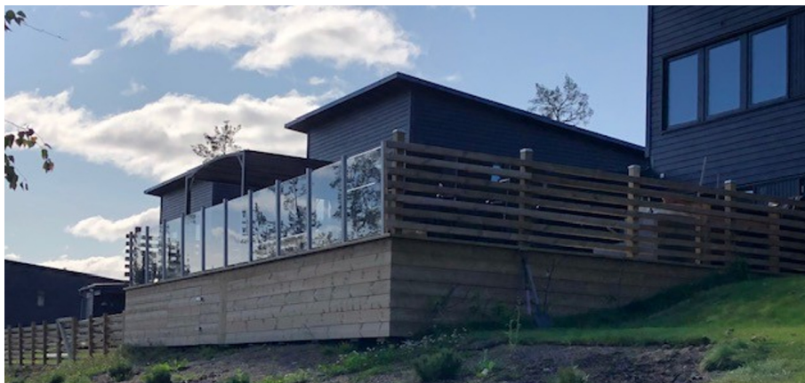
Bild 2 den aktuella altanen med ett lägre förråd med dörr under altangolv
