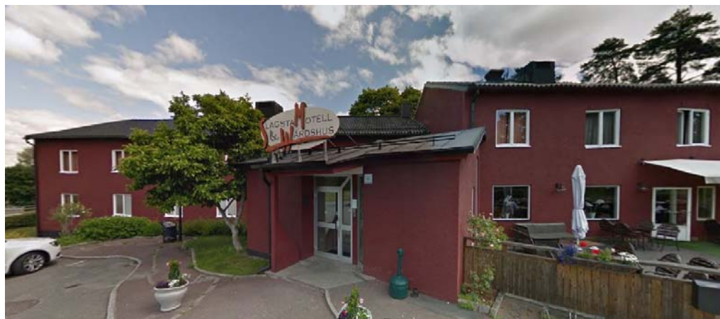
Vy mot befintlig byggnad från sydväst.
