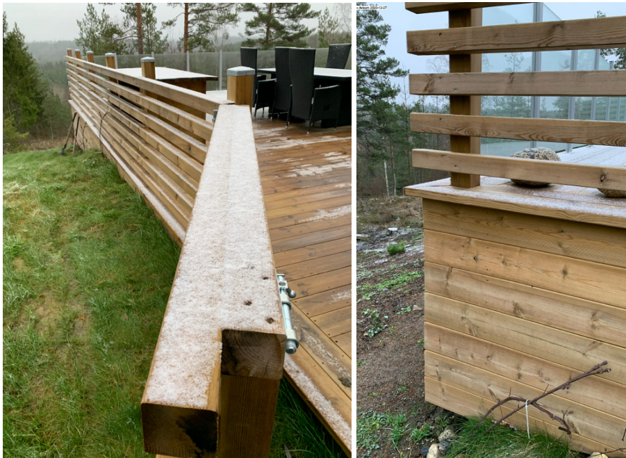
Bild 4 – sökandens egna bilder redovisar att på grund av att räcken/planket uppbyggd av ribbor (tjocka reglar) upplevs de som täta plank. Endast på nära håll och rakt framifrån syns att genomsynligheten ca 50%.
