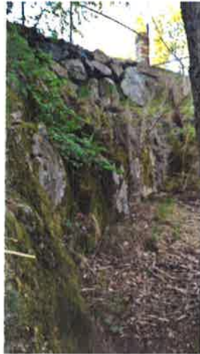
Foto 6 – Berg i dagen och befintlig terrassmur
