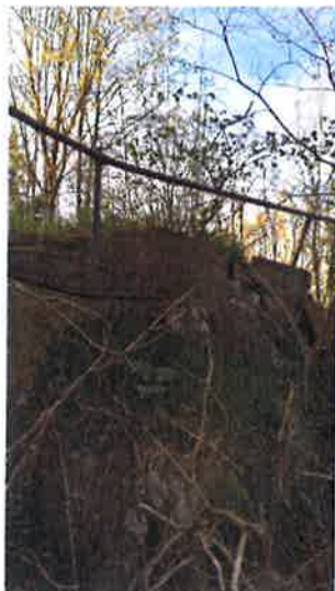
Foto 9 – Berg i dagen och befintlig terrassmur av betong
