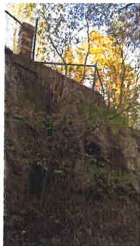
Foto 7 – Berg i dagen och befintlig terrassmur
