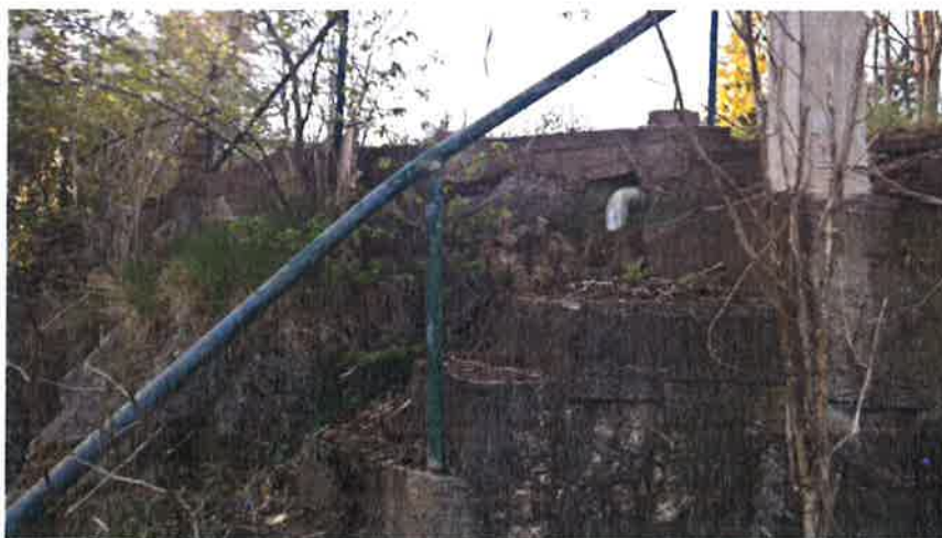
Foto 8 – Berg i dagen och befintlig stentrappa
