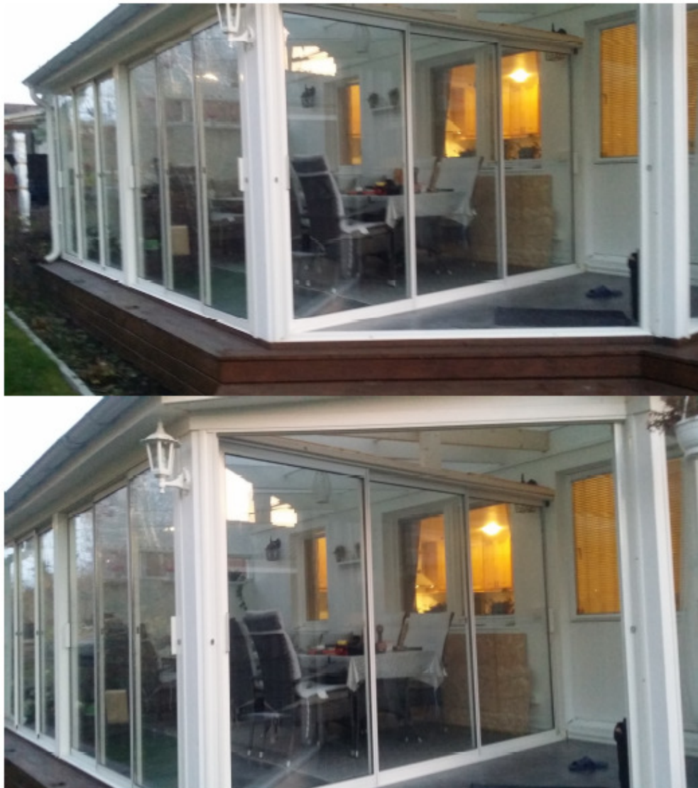
Bild 4 är ytterligare dokumentation som visar att rättelsen har skett
