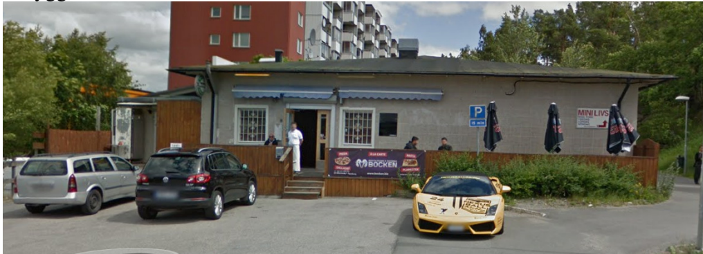
Byggnaden innan branden
