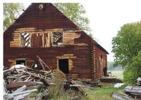
Det är rejält stora hus som monteras ner.
