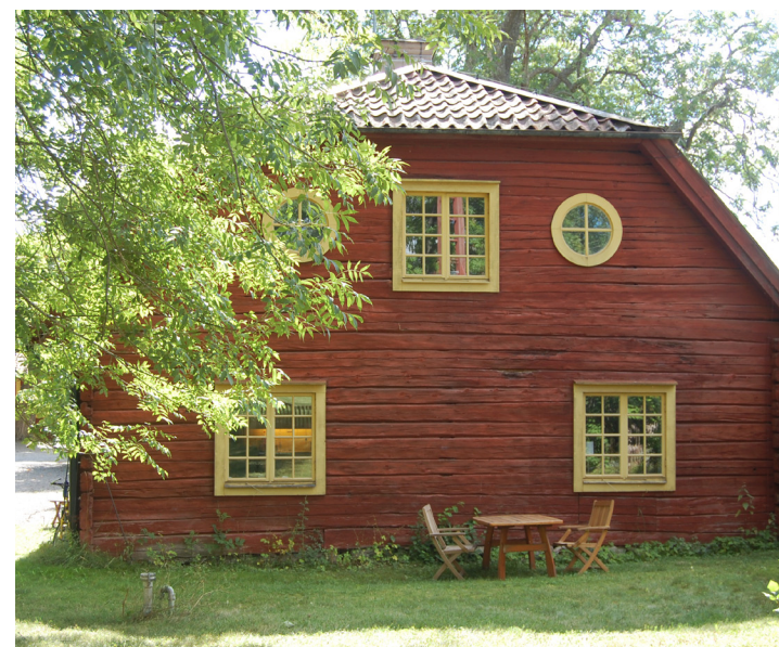
I flygelbyggnaderna är den timrade konstruktionen synlig i fasaden. Ursprungligen flankerades herrgården av fyra flyglar men sedan 1910-talet finns endast dessa två kvar. Det är två välbevarade byggnader, sannolikt från 1700-talet, med bibehållen äldre karaktär.
