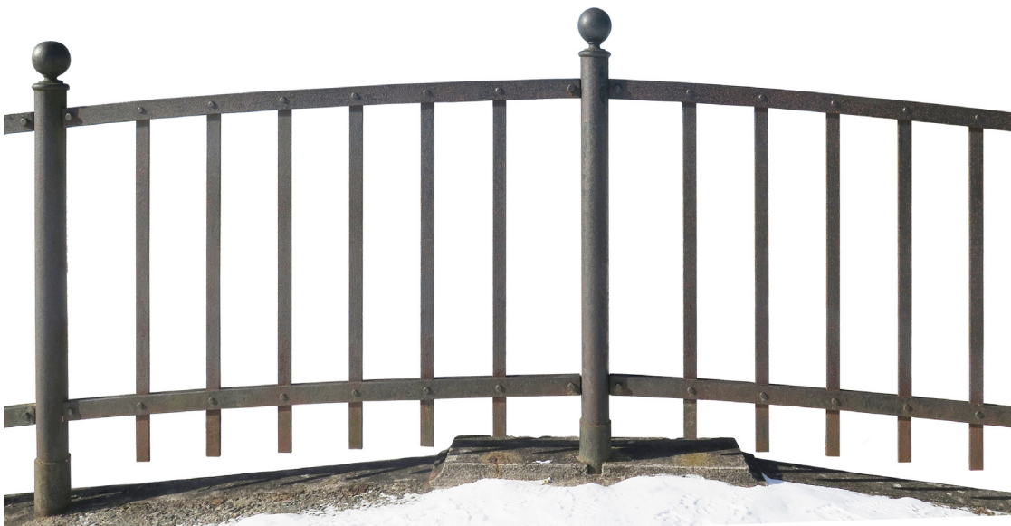
Utsnitt av räcke gjort av hopnitade plattstål. Pelaren till höger är placerad på brons mitt.
