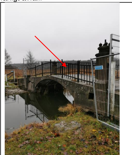
Bild 1. Rostskyddsfärgen innehåller blymönja.
