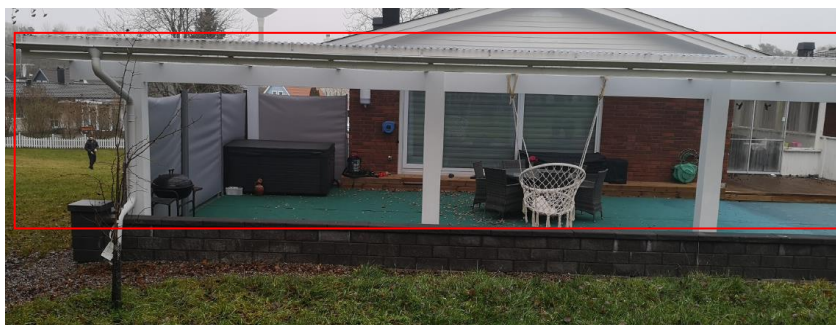
Skärmtak foto taget från kommunens fastighet.
