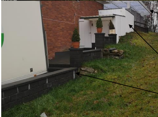
Taksprång utanför fastighetsgräns över Botkyrka kommuns allmänna mark
